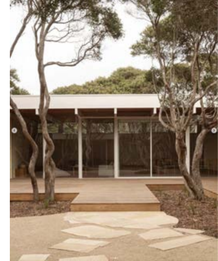
možnost mlát u přechodů lokálně zpevnit kameny
