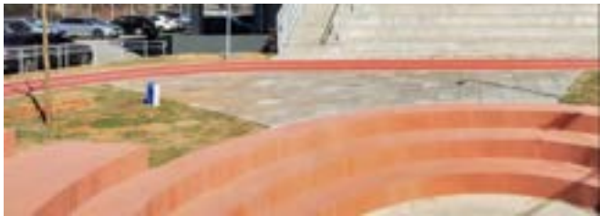
zvýšené sezení u atletické dráhy - probarvený beton
