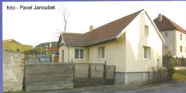
foto po opravě
