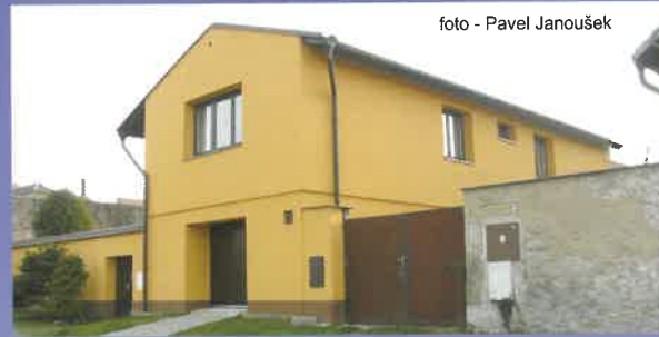
foto po opravě
