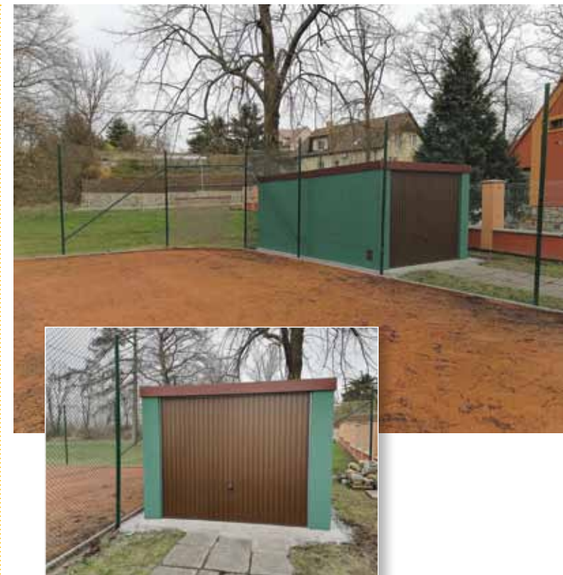
Za pomoci obce se podařilo na kurtech vybudovat sklad techniky a nářadí.
