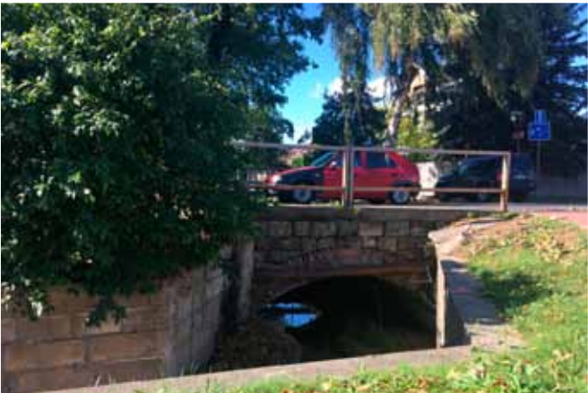
Tento několik málo metrů dlouhý mostek chtěla správa silnic opravovat 214 dnů, nakonec se nám ji podařilo donutit ke zkrácení na „pouhých“ 140 dnů...
