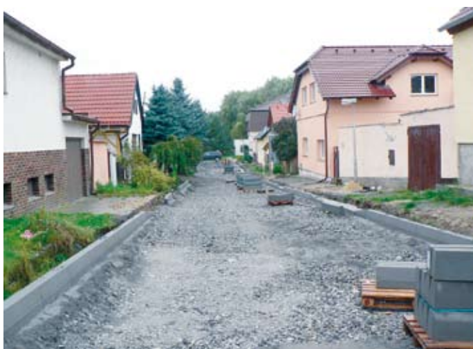
Stavební práce v Radonicích
